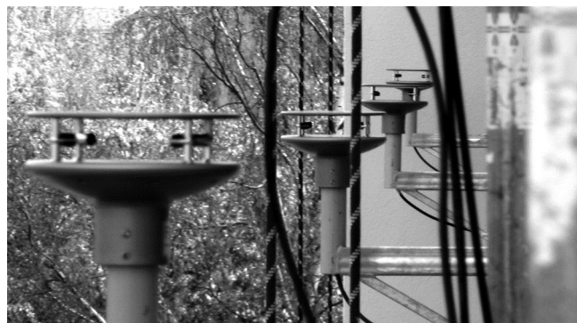
Rys. 14. Grupa czujników zamontowana na rusztowaniu elewacyjnym
