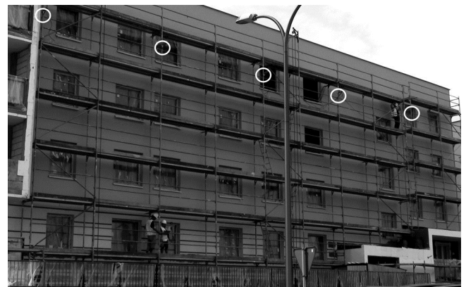
Rys. 12. Obiekt z zaznaczonymi punktami montażu czujników
