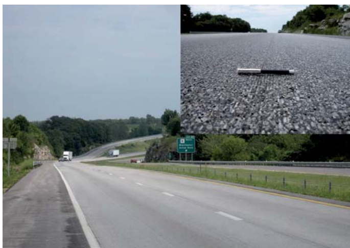
Fot. 10. Przykład zastosowania zabiegu diamentowego szlifowania na asfaltowej nawierzchni drogi I-70, stan Missouri [7]
