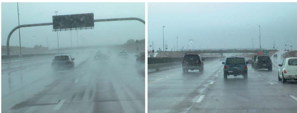
Fot. 12. Zmniejszenie rozprysku wody oraz mgły wodnej przez koła pojazdów (ang. splash and spray) w wyniku zabiegu typu grooving na nawierzchni w czasie opadów deszczu [7]
