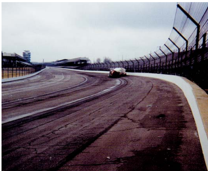
Fot. 9. Przykład zastosowania zabiegu diamentowego szlifowania na asfaltowej nawierzchni toru wyścigowego w Indianapolis, stan Indiana [7]
