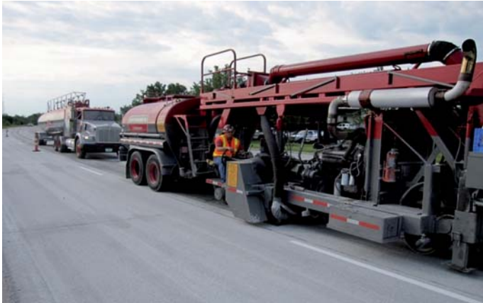
Fot. 2. Zestaw maszyn do wykonania zabiegu nacinania i rowkowania nawierzchni (G&G) [7]
