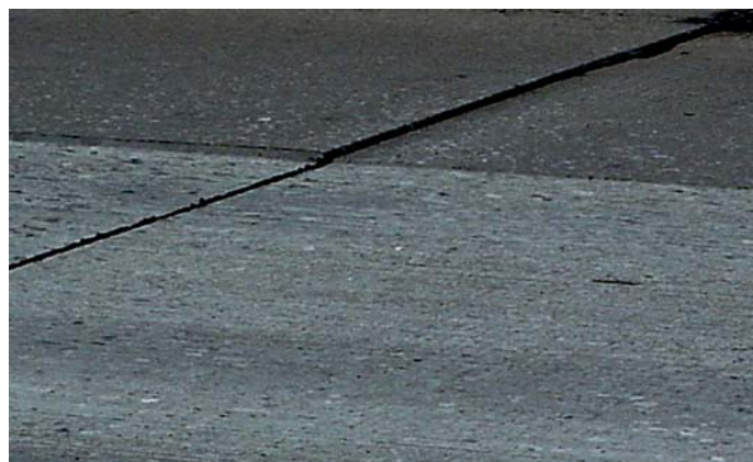
Fot. 8. Przykład usunięcia klawiszowania płyt poprzez zastosowanie zabiegu CDG na jednym pasie jezdni betonowej [7]
