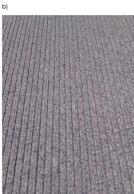
Fot. 1. Tekstura nawierzchni uzyskana w wyniku podłużnego nacinania i rowkowania: a) widok nawierzchni wraz z fragmentem oznakowania poziomego; b) zbliżenie powierzchni nawierzchni (fot. W. Zapaśnik)
