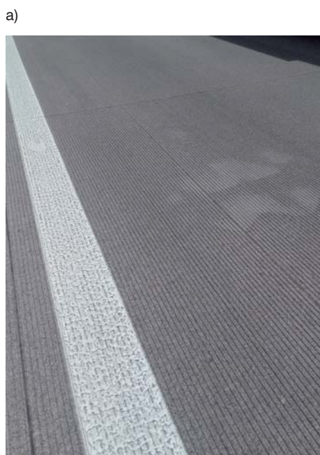
Fot. 1. Tekstura nawierzchni uzyskana w wyniku podłużnego nacinania i rowkowania: a) widok nawierzchni wraz z fragmentem oznakowania poziomego; b) zbliżenie powierzchni nawierzchni (fot. W. Zapaśnik)
