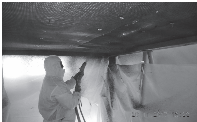
Rys. 6. Natrysk Cafero FENDOLITE® MII na próbkę B
