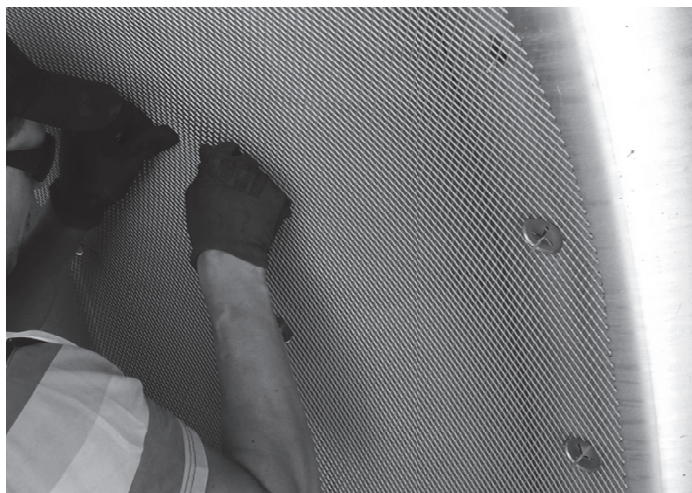
Rys. 3. Instalacja membrany z siatki cięto-ciągnionej
