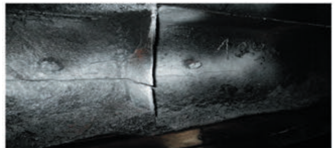
Rys. 9. Jedno z wielu uszkodzonych miejsc na konstrukcji wywrotnicy [2]
