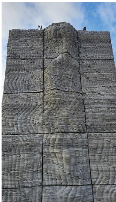
Rys. 2. Przykład przestrzennej wielkoformatowej struktur wykonanych w technologii druku 3D
