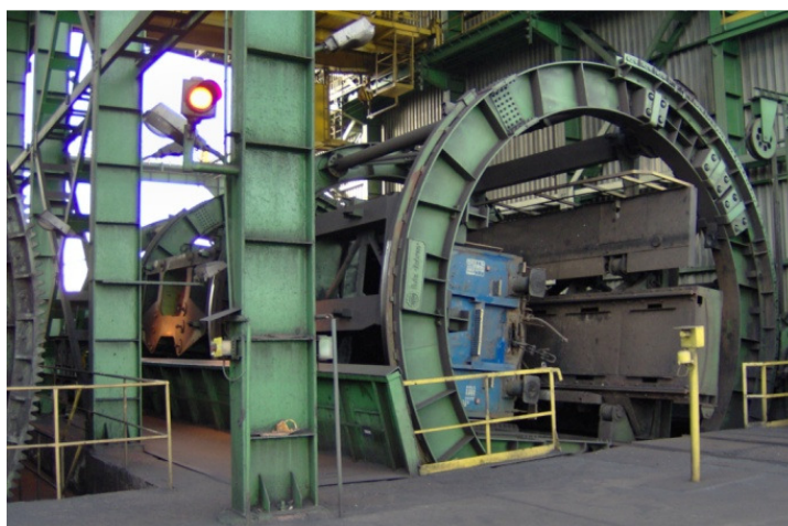
Rys. 1. Wywrotnica wagonowa – strona wyjazdowa (opracowanie własne)
