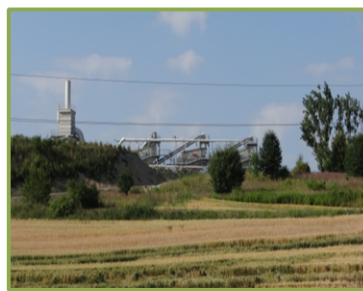
Rys.13. Widok Kopalni Granitu Wieśnica (fot. M. Stefanicka)
