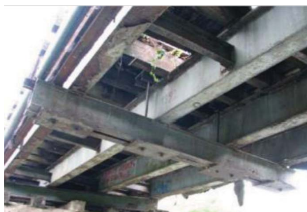
Rys. 5. Widok spodu konstrukcji mostu, stan w 2009 roku. Źródło: [4]
