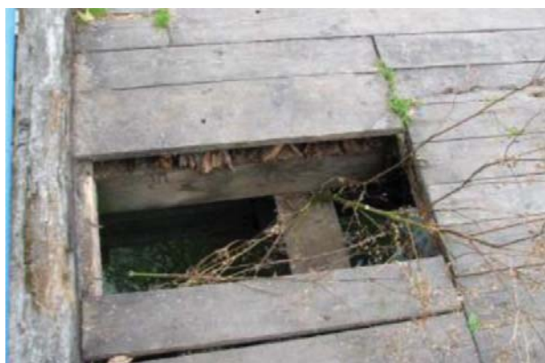
Rys. 4. Widok nawierzchni, stan w 2009 roku. Źródło: [4]
