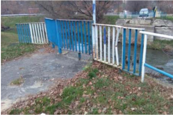
Rys. 8. Balustrady zabezpieczające przyczółki. Źródło: [6]
