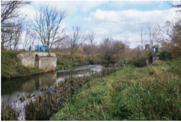
Rys. 7. Widok pozostałości mostu po rozbiórce. Źródło: [5, 6]
