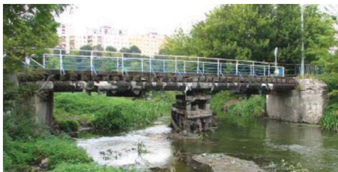
Rys. 3. Widok ogólny mostu, stan w 2009 roku. Źródło: [4]
