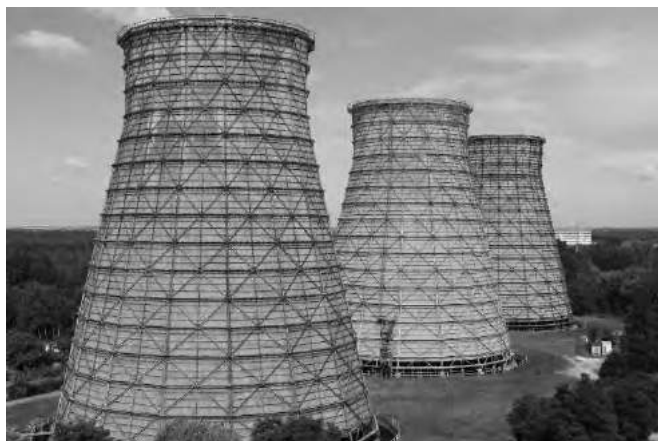
Rys. 5. Chłodnie kominowe elektrowni Halemba
