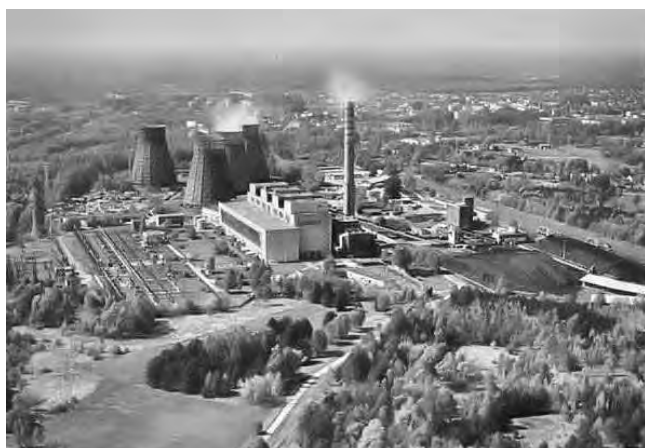
Rys. 3. Widok na elektrownię Halemba w latach 60.
