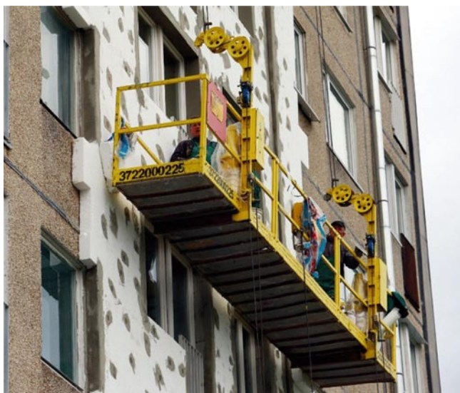
Rys. 5. Termomodernizacja ściany trójwarstwowej w budynku wielokopłytowym
