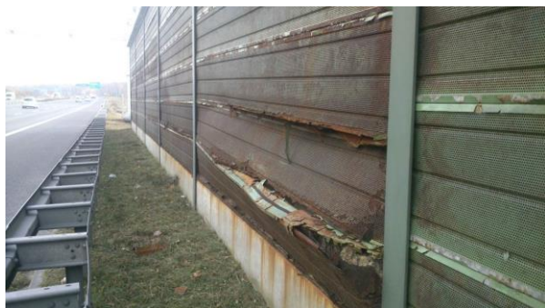
Rys. 2. Zniszczenia stalowych paneli ekranu akustycznego. Fig. 2. Destruction of steel acoustic screen panels.
