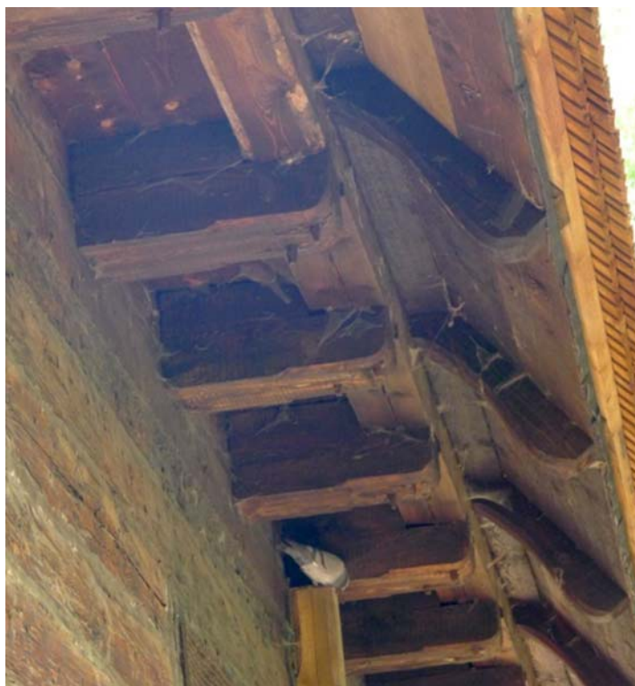
Ryc. 6. Krokwie wystające poza belkę okapową. Belka okapowa dachu oparta na wysuniętych wspornikowo belkach stropowych Fig. 6. Rafters protruding beyond the eaves beam. The eaves beam is supported by protruding structural ceiling joists
