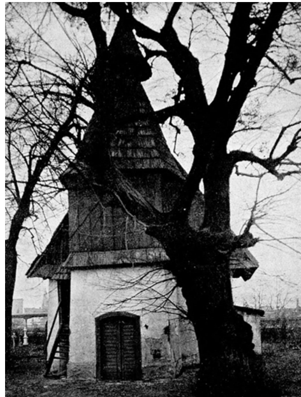
Ryc. 2. Widok kościoła znajdującego się jeszcze w Kędzierzynie. Widoczne otynkowane ściany partii dolnej. Fotografia z 1903 r. (źródło: http://dolny-slask.org.pl )
