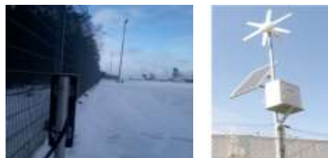
Rys. 1. Fragment obwodowej ochrony perymetrycznej Fig. 1. The fragment of the district perimetric protection
