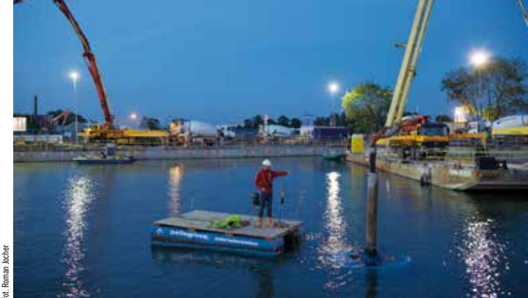
Prace przy wykonywaniu korka betonowego w wykopie
