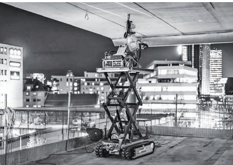
Rys. 5. Robot mobilny wykonujący instalację sufitów podwieszanych – aplikacja pozwala na 1,5× szybszy montaż płyt niż w przypadku dwuosobowej ekipy budowlanej, sterowanie zapewnia bieżące przysyłanie instrukcji ze środowiska BIM (ang. Building Information Modeling ), wykorzystując dynamiczny model informacji budowlanych 3D, Skanska Norway 2016
