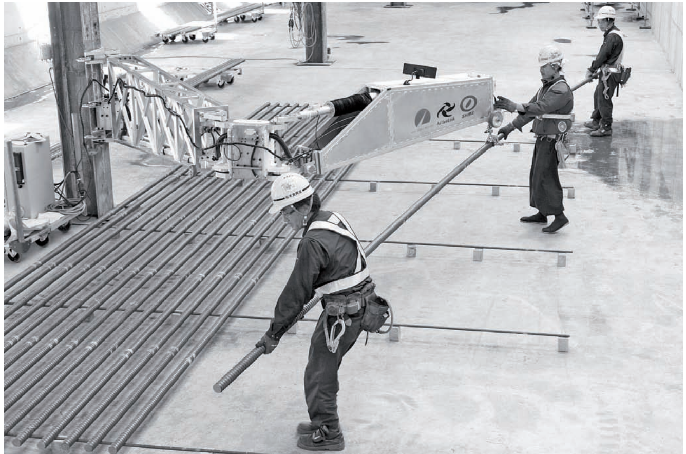
Rys. 15. Robotyzacja prac budowlanych w małej skali w Japonii: serwooperator korporacji Shimizu Corp., sterowany przez jednego z pracowników, pomaga innym pracownikom budowlanym w układaniu ciężkich prętów stalowych
