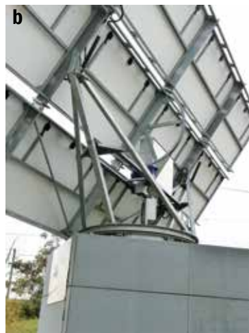
Rys. 9. Solar Mover – zielona energia na dworcu kolejowym Berlin Südkreuz: a) widok z przodu – dwunastu modułów solarnych stanowiących jeden element; b) widok z tyłu – ruchomej konstrukcji modułów solarnych względem promieni słońca Źródło: archiwum autora.
