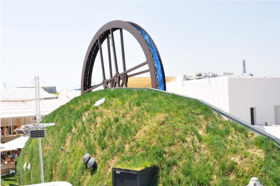
Ryc. 12. Pawilon Białorusi, Expo 2015. Źródło: fot. M. Rzeszotarska-Pałka Fig. 12. Belarus Pavilion, Expo 2015. Source: photo M. Rzeszotarska-Pałka
