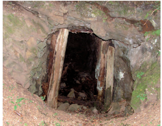
Fig. 11. The Lejowe Banie 1 adit – the entrance to the mine, phot. A. Ziemianek • Sztolnia Lejowe Banie 1 – wejście do sztolni, fot. A. Ziemianek
