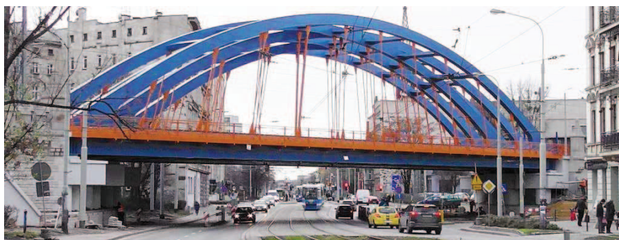
Rys. 1. Widok ogólny od strony Grabiszyna na wiadukt nad ul. Grabiszyńską we Wrocławiu. Źródło: fotopolska.eu
