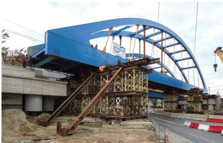
Rys. 7. Przęsło nr 2 w trakcie dosunięcia poprzecznego na pozycję docelową, w ós toru nr 2 linii nr 271
