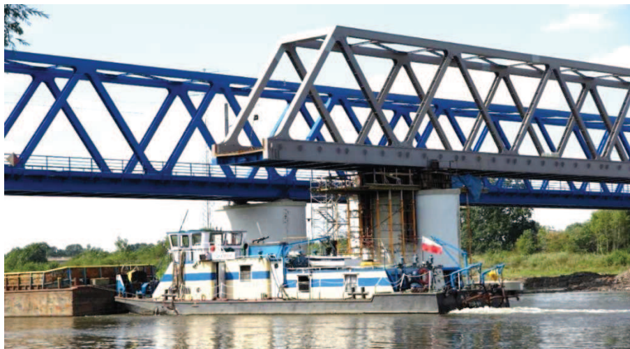
Rys. 14. Operacja wspornikowego nasuwu podłużnego przęsła wschodniego (tor nr 1)
