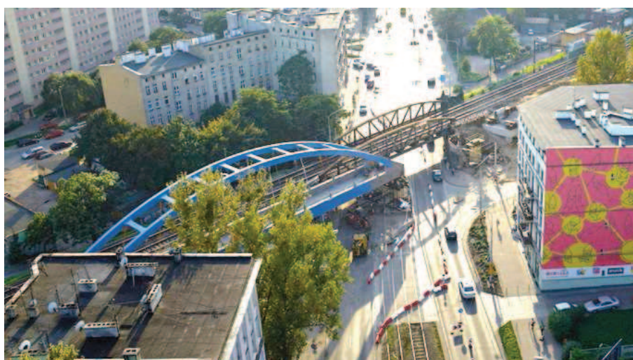
Rys. 5. Przęsło nr1 w trakcie procedury nasuwania nad jezdnię ul. Grabiszyńskiej. źródło: fotopolska.eu
