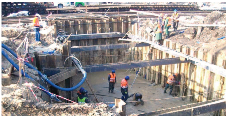
Rys. 17. Widok na komorę zamkniętą w obudowanie ze ścian szczelnych, zabezpieczonych rozpórami
