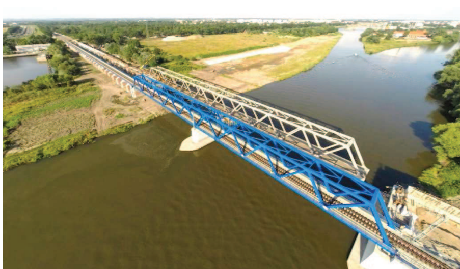
Rys. 15. Operacja wspornikowego nasuwu podłużnego przęsła wschodniego (tor nr 1) – faza końcowa
