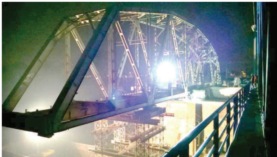
Rys. 12. Operacja zsunęcia istniejącego przęsła w torze nr 2. Widok na podporę pływającą
