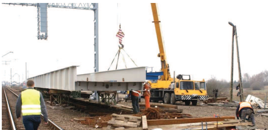
Rys. 20. Wstępne scalenie konstrukcji mostu nad rz. Sowiną przed transportem żurawiem na podwoziu samochodowym do docelowego miejsca wbudowania
