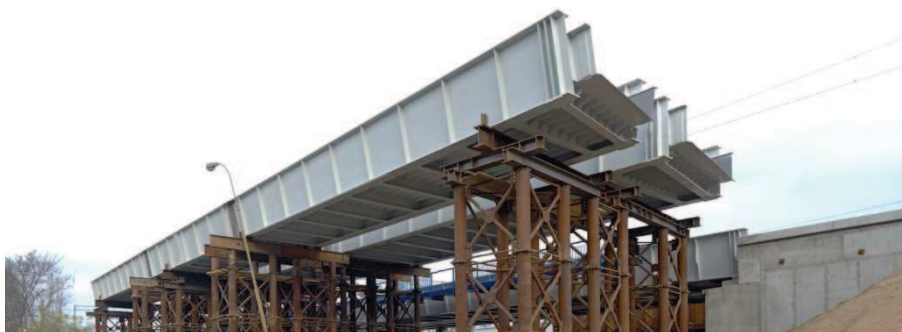
Rys. 9. Przęsła wiaduktu nad ul. Starogroblową we Wrocławiu przed nasunięciem poprzecznym w miejsce docelowe tzn. w oś torów wewnętrznych. Źródło: fotopol-ska.eu
