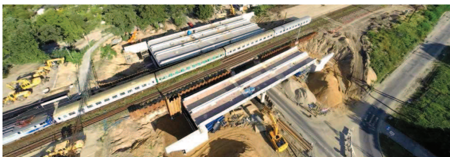
Rys. 8. Wiadukt nad ul. Starogroblową. Stan przed montażem dwóch konstrukcji przęseł dla torów wewnętrznych (blachownice ciągłe 2-przęsłowe)
