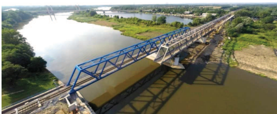
Rys. 13. Operacja wspornikowego nasuwu podłużnego przęsła wschodniego (tor nr 1) – przekroczenie filara nurtowego
