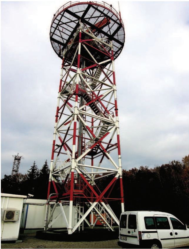
Rys. 1. Widok istniejącej konstrukcji wieży
