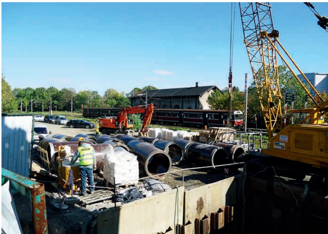
Ryc. 3. Plac budowy z rurami DN 1400 mm
