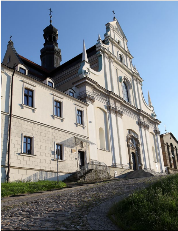
Ryc. 4. Widok na elewację frontową; fot. R. Piejko. Fig. 4. View of the frontal facade; photo by R. Piejko.
