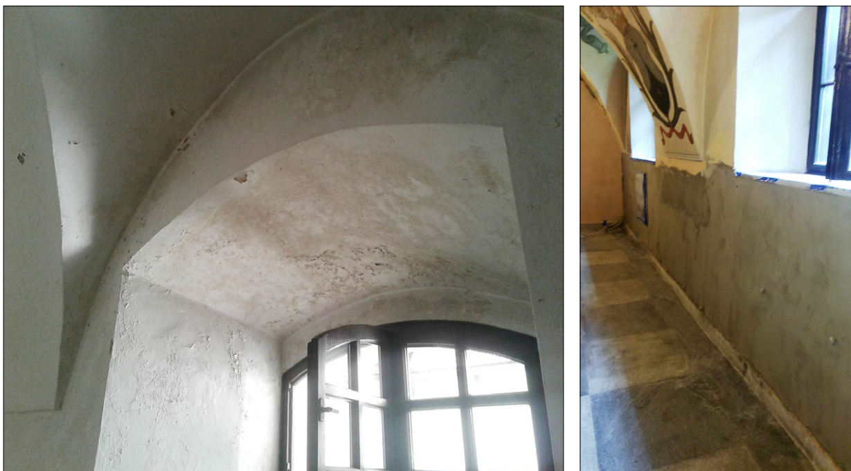
Ryc. 10. Pomieszczenia wewnętrzne przed pracami konserwatorskimi i w ich trakcie; fot. K. Sikorski.
