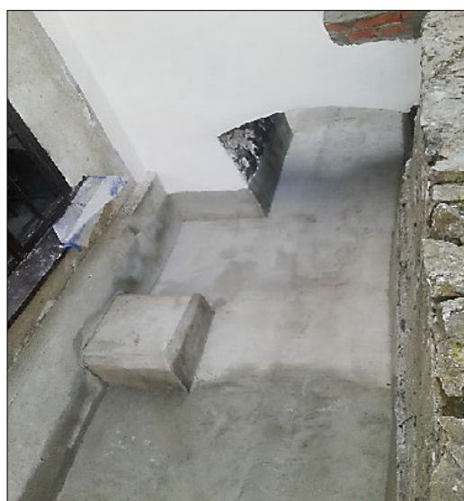
Ryc. 9. Kanał burzowy przed pracami renowacyjnymi i w ich trakcie; fot. K. Sikorski, K. Lewandowska.
