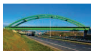
Rys. 4. Wiadukt WK-9 w ciągu obwodnicy Torunia
