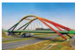
Rys. 5. Wiadukt WD 161 Autostrada A2
