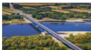
Rys. 7. Most przez rzekę Wisłę w miejscowości Kamień
