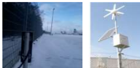
Rys. 1. Fragment obwodowej ochrony perymetrycznej Fig. 1. The fragment of the district perimetric protection
