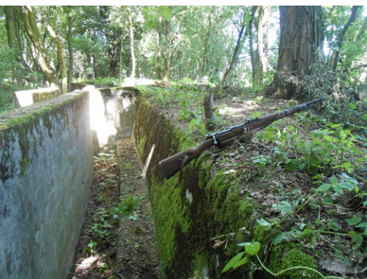
Ryc. 3. Betonowa pozycja strzelecka na forcie piechoty nr 6, 2014 (fot. Ł. Pardela)
