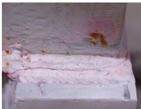
Rys. 4. Nieciągłości w spoinie pachwinowej ujawnione metodą penetracyjną
