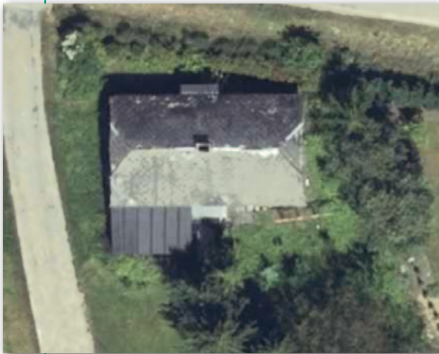
Pokrycie azbestowo-cementowe typu „karo”
