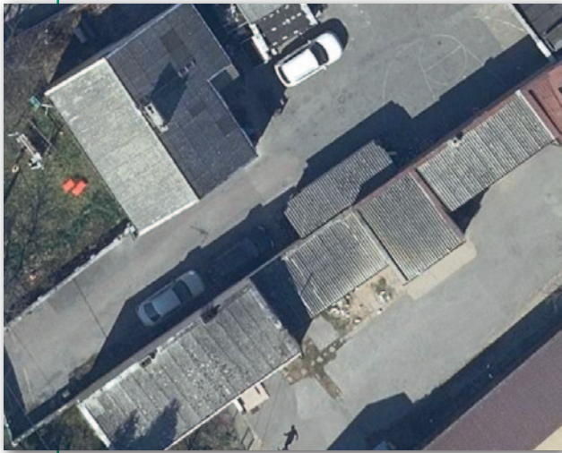
Na ortofotomapie widoczne pokrycie dachu płytą falistą
