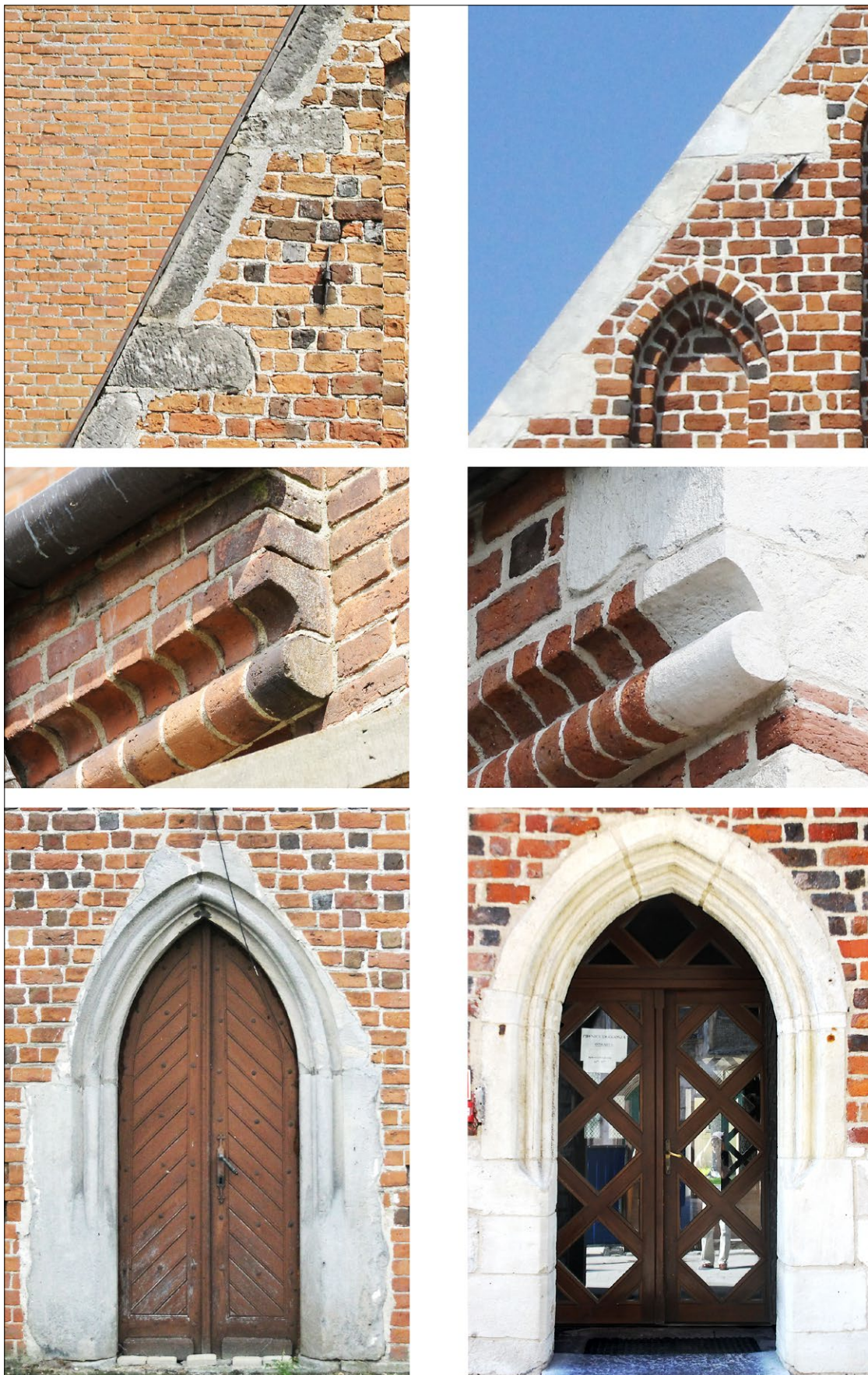
Ryc. 10. Zestawienie elementów architektonicznych: fragment obwodu szczytu, gzyms, portal. Z lewej: kościół w Odechowie, z prawej: dom kanoników w Wiślicy, rok 2021; fot. J. Czechowicz.
