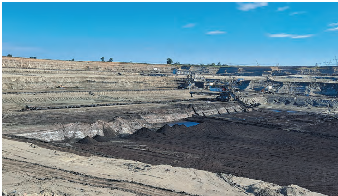
Ryc. 11. Odkrywka Tomisławice z odsłoniętym stropem eksploatowanego pokładu węgla brunatnego i skarpami oraz poziomami zbierania nadkładu glin zwałowych. Fot. J. Przybyłek, lipiec 2022 r.
