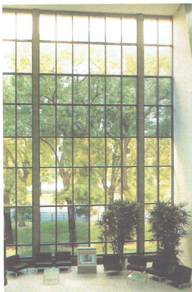
Rys. 5. Przykłady zastosowania szkieł z powłokami elektrochromowymi. Powszczególne elementy oszklenia mogą pozostawać w stanie rozjaśnionym (bezbarwnym) lub zabarwionym (w stopniu regulowanym), będąc przy tym przezroczyste, (Econtrol, Architectural products, Flaberg GmbH & Co. KG.)
