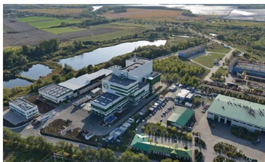
Rys. 6. Zakład Unieszkodliwiania Odpadów Komunalnych w Koninie i Spalarnia Maishima, Osaka w Japonii
