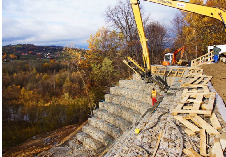
Osuwisko w ciągu drogi Jarostowa–Łososina zabezpieczone przez kotwioną barierę mikropalową u podnóża oraz konstrukcją gwoździowaną z gabionami z jednoczesną odbudową zniszczonego korpusu drogowego, fot. Titan Polska Sp. z o.o.
