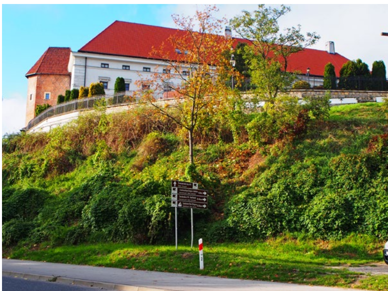
Stabilizacja skarpy osuwiskowej w bezpośrednim sąsiedztwie zamku w Sandomierzu za pomocą systemu gwoździ gruntowych TITAN z oblicowaniem elastycznym, dzisiaj całkowicie zasłonięte roślinnością, fot. Titan Polska Sp. z o.o.
