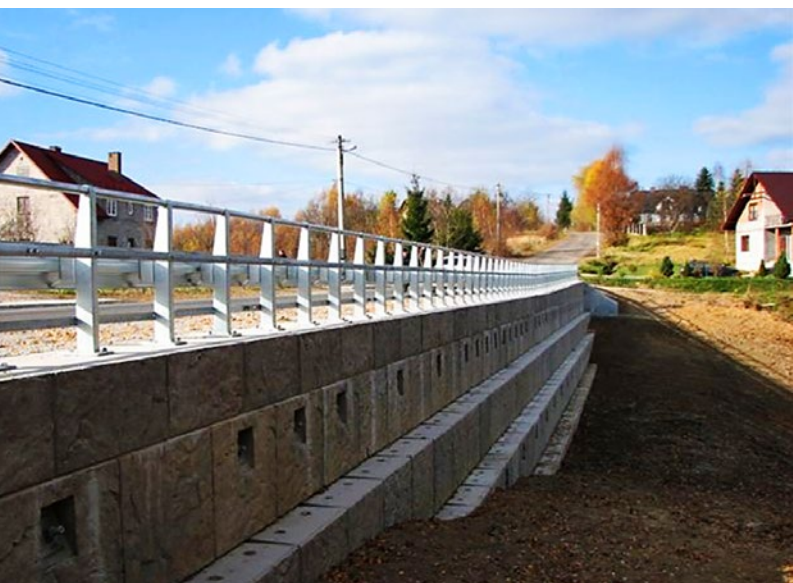
Odbudowa drogi i stabilizacja osuwiska konstrukcją z muru oporowego z prefabrykatów, posadowionego na barierze mikropalowej i kotwionego w kilku rzędach mikropalami TITAN, Bieńkowiec, fot. Titan Polska Sp. z o.o.
