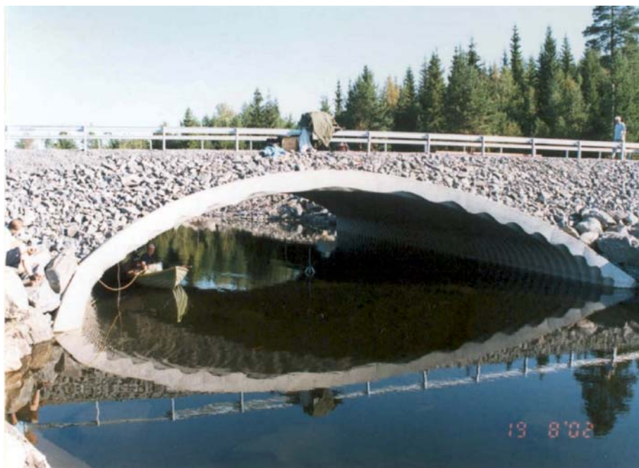
Fot. 1. Widok z boku na most gruntowo-powłokowy
