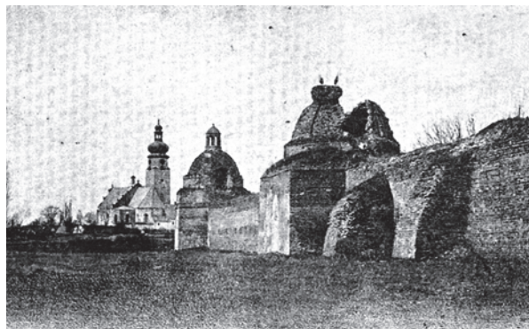
Ryc. 5. Relikty umocnień obronnych klasztoru sióstr Brygidek w Sokalu na pocz. XX wieku, a ich tle umocnienia obronne i klasztor oo. Bernardynów na archiwalnej pocztówce [w:] archiwum prywatne autorki
