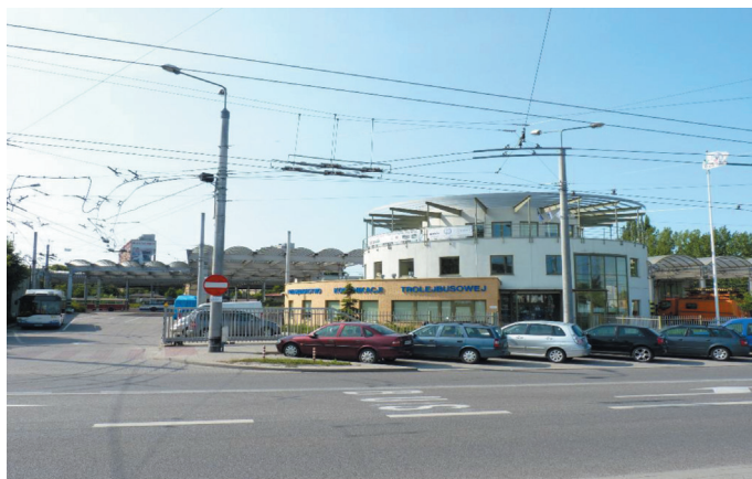
Fot. 1. Zajezdnia trolejbusowa przy ul. Zakręt do Oksywia 1 w dzielnicy Leszczynki Źródło: www.pktgdynia.pl (dostęp z dn. 01.01.2015 r.).
