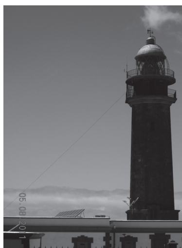
Rys. 2. Latarnia morska Faro de Orchilla zasilana energią w wyniku konwersji fotowoltaicznej na płaskim dachu, po lewej, widoczny panel PV [Foto autora]
