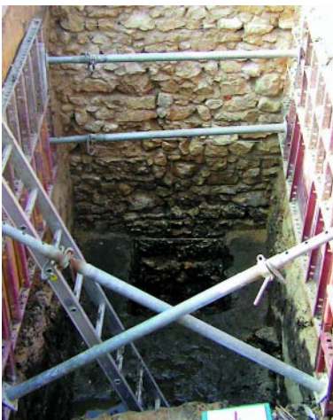
Wykop w rejonie północno-wschodniego narożnika Sukiennic wykonany w 2003 roku, z odsłoniętą wschodnią ścianą kamienną zachodniego traktu kramów z widocznym regularnym i wyrównywanym warstwowo wątkiem kamiennym (fot. autor)
