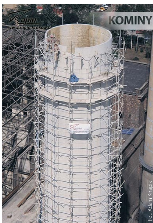
Rys. 1. Demontaż komina metodą cięcia
