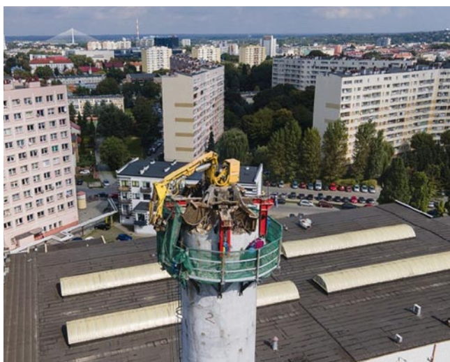
Rys. 2. Demontaż kominu metodą mechaniczną
