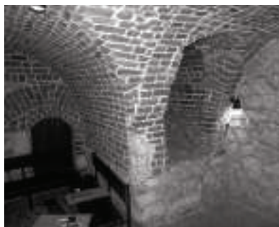
Ryc. 11. Klasztor augustianów, piwnica traktu zachodniego skrzydła wschodniego, widok pieca grzewczego w północno-zachodnim narożniku pomieszczenia. Fot. A. Bojęś-Białasik, 2009 Fig. 11. Augustinian monastery, cellars of the west course of the east wing, view of the heating stove in the north-west corner of the room. Photo by: A. Bojęś-Białasik, 2009
