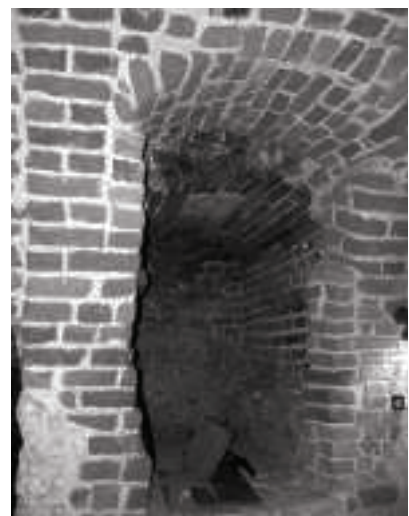
Ryc. 13. Widok ściany południowej pieca z otworem wlotowym, w głębi widoczne wnętrze komory. Fot. A. Bojęś-Białasik, 2009 Fig. 13. View of the south wall of the stove with the inlet, in the background the chamber interior. Photo by A. Bojęś-Białasik, 2009
