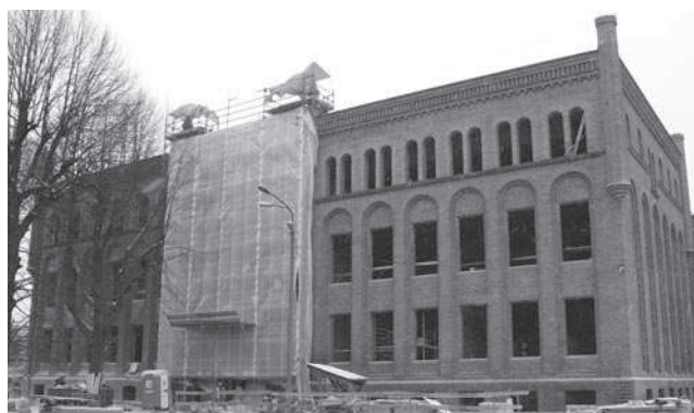
Rys. 1. Widok budynku zlokalizowanego przy ul. Lastadia 2 w Gdańsku (zdjęcie: autor)
