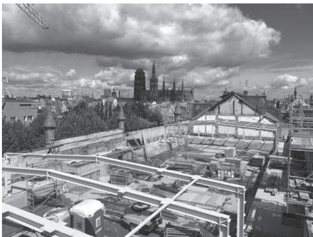
Rys. 3. Budynek przy ul. Lastadia 2 – widok konstrukcji dachu i stropu ostatniej kondygnacji (zdjęcie: autor)
