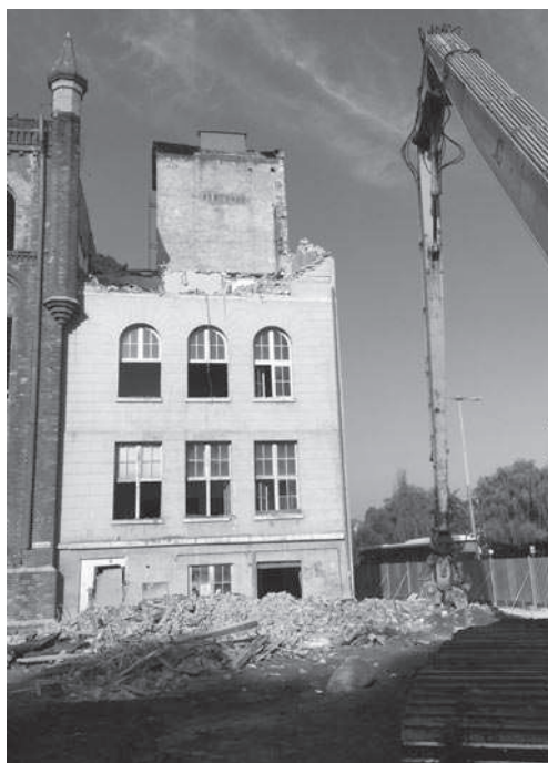
Rys. 2. Budynek przy ul. Lastadia 1 w trakcie rozbioru, stan na 16.10.2018 r. (zdjęcie: autor)
