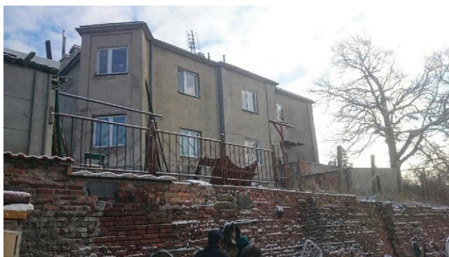
Rys. 3. Widok budynku od strony muru oporowego
