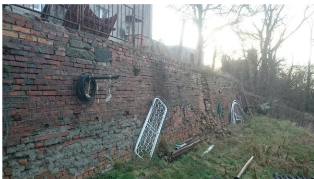
Rys. 4. Widok ceglaneanego muru oporowego
