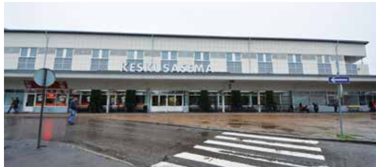
Dworzec pasażerski na stacji Imatra (13.09.2017 r.)
