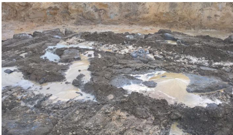
Rys. 5. Przykład niewłaściwie przygotowanej powierzchni roboczej uniemożliwiającej prowadzenie prac (brak materiału ziarnistego, brak zagęszczenia, brak odwodnienia) [10]
