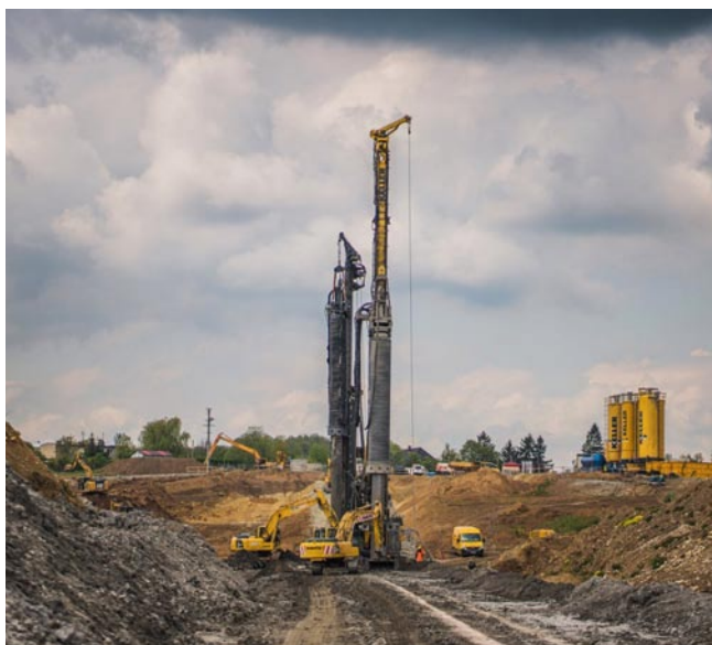
Rys. 9. Palownice do pali VDW wyposażone w rękawy odprowadzające urobek
