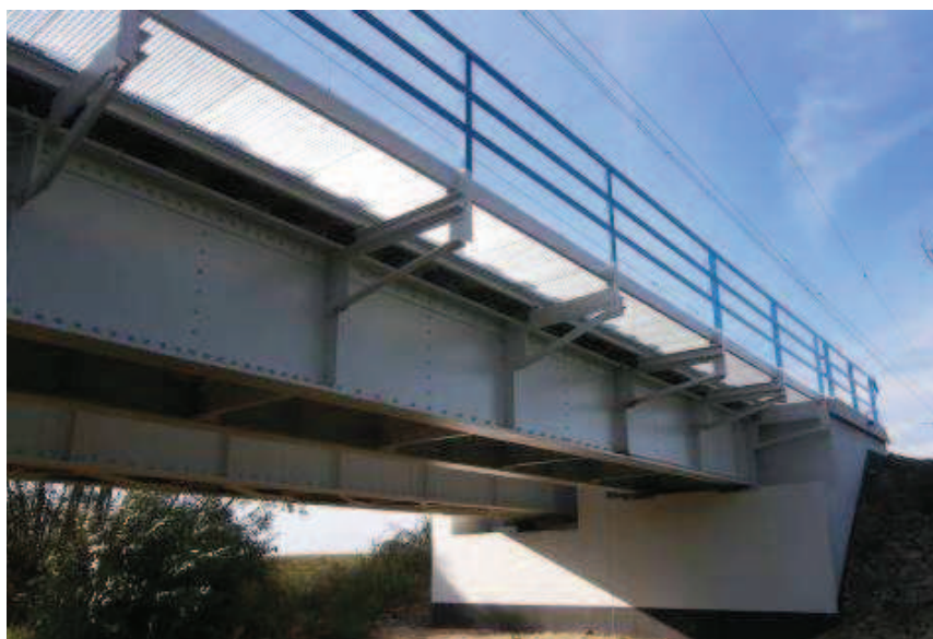
Rys. 20. Most w km 4,010 po remoncie
