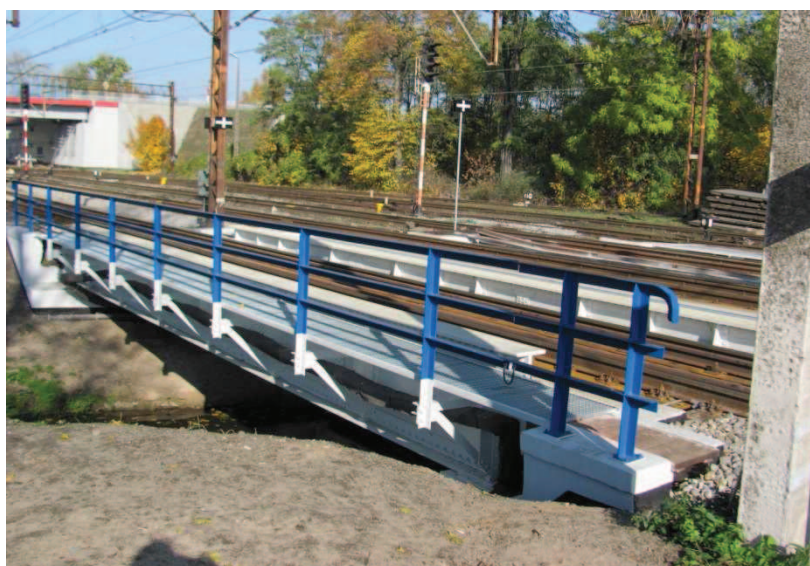
Rys. 18. Most w km 0,227 po remoncie
