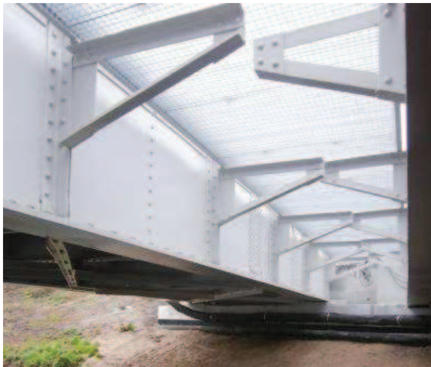
Rys. 19. Most w km 0,227 po remoncie
