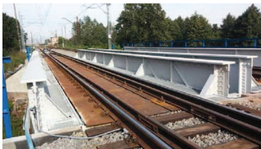
Rys. 22. Most w km 22,980 po remoncie
