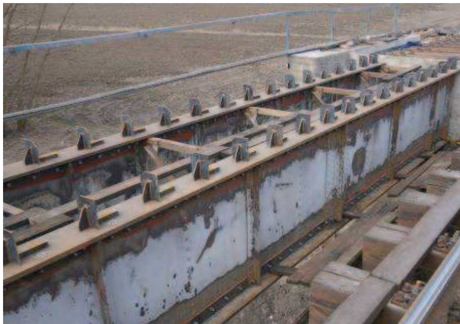
Rys. 11. Dźwigary główne po montażu nowych elementów konstrukcyjnych km 4,010
