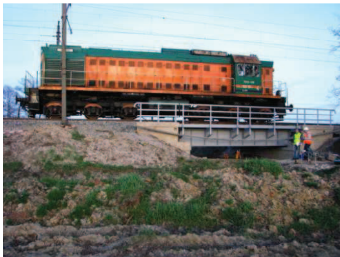
Rys. 16. Próbné obciążenia mostu w km 5,311
