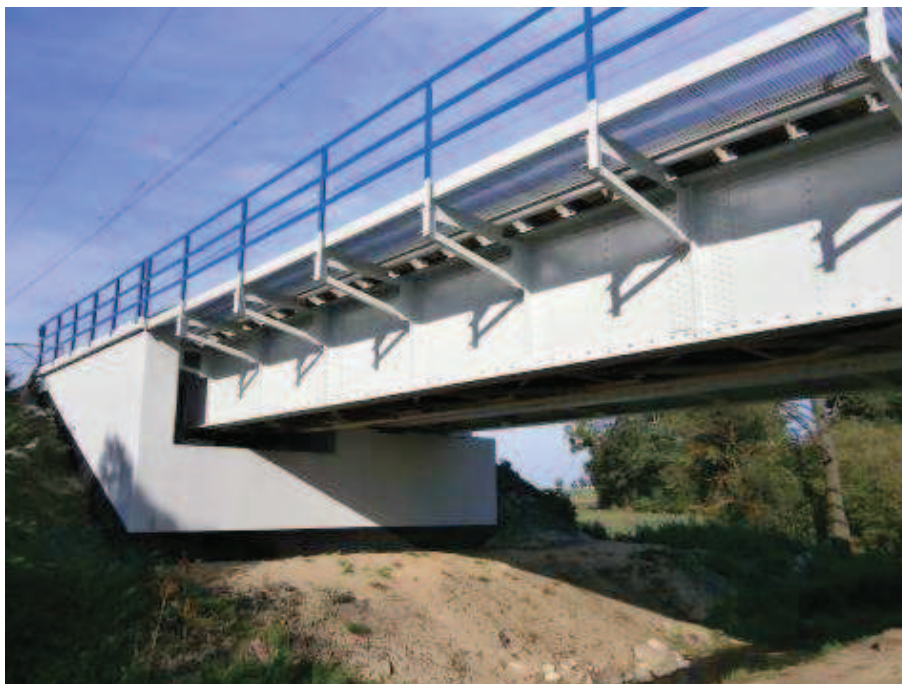
Rys. 14. Most w km 4,010 po wykonaniu remontu
