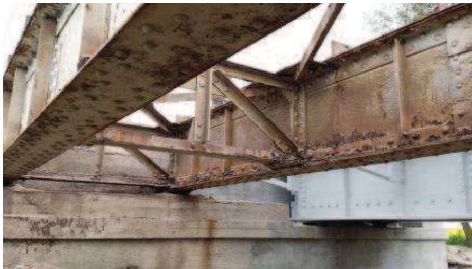
Rys. 11. Most w km 4,010 – tor nr 2 przęsło po demontażu nawierzchni
