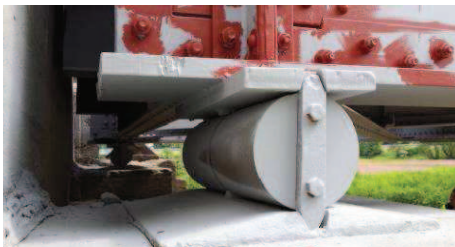
Rys. 13. Łożysko mostu w km 22,980 po renowacji
