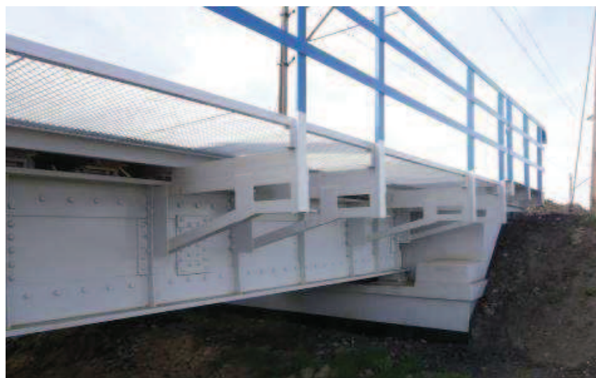
Rys. 21. Most w km 5,311 po remoncie
