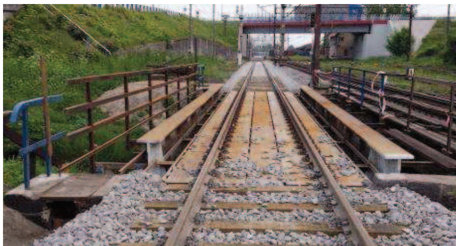
Rys. 12. Most w km 0,227 po montażu nowej nawierzchni torowej.
