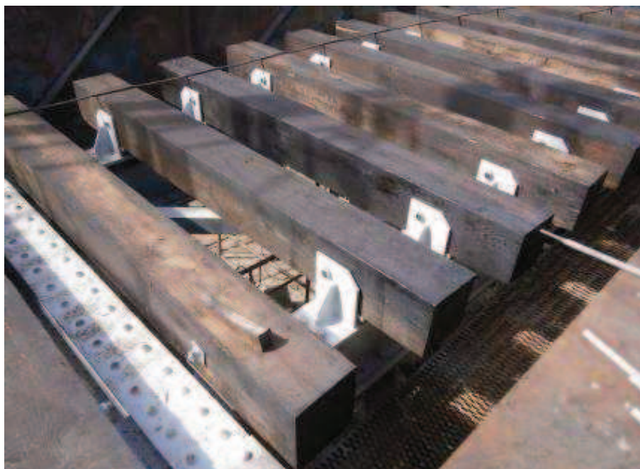
Rys. 12. Montaż mostownic km 22,980
