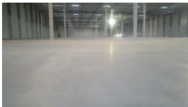
Rys. 2. Posadzka bezspoinowa utwardzona powierzchniowo [5] (archiwum autorów)
