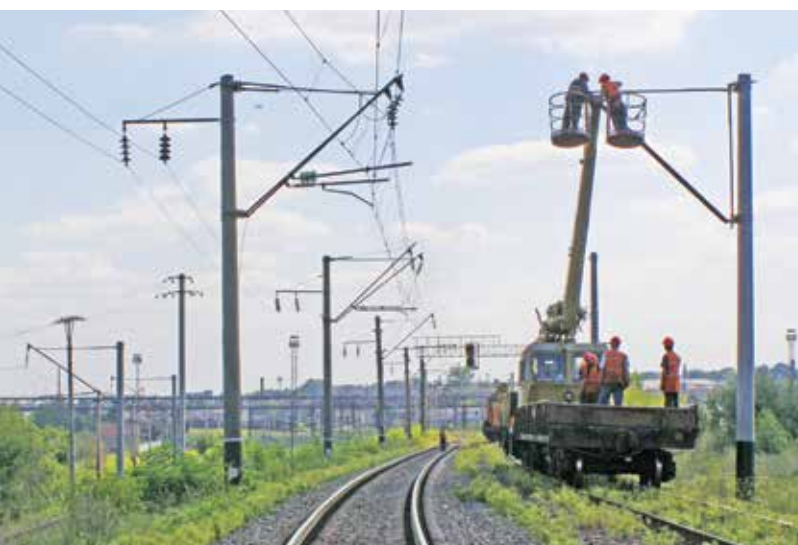
Elektryfikacja sieci kolejowej w Równem. Fot. A. Brynych
