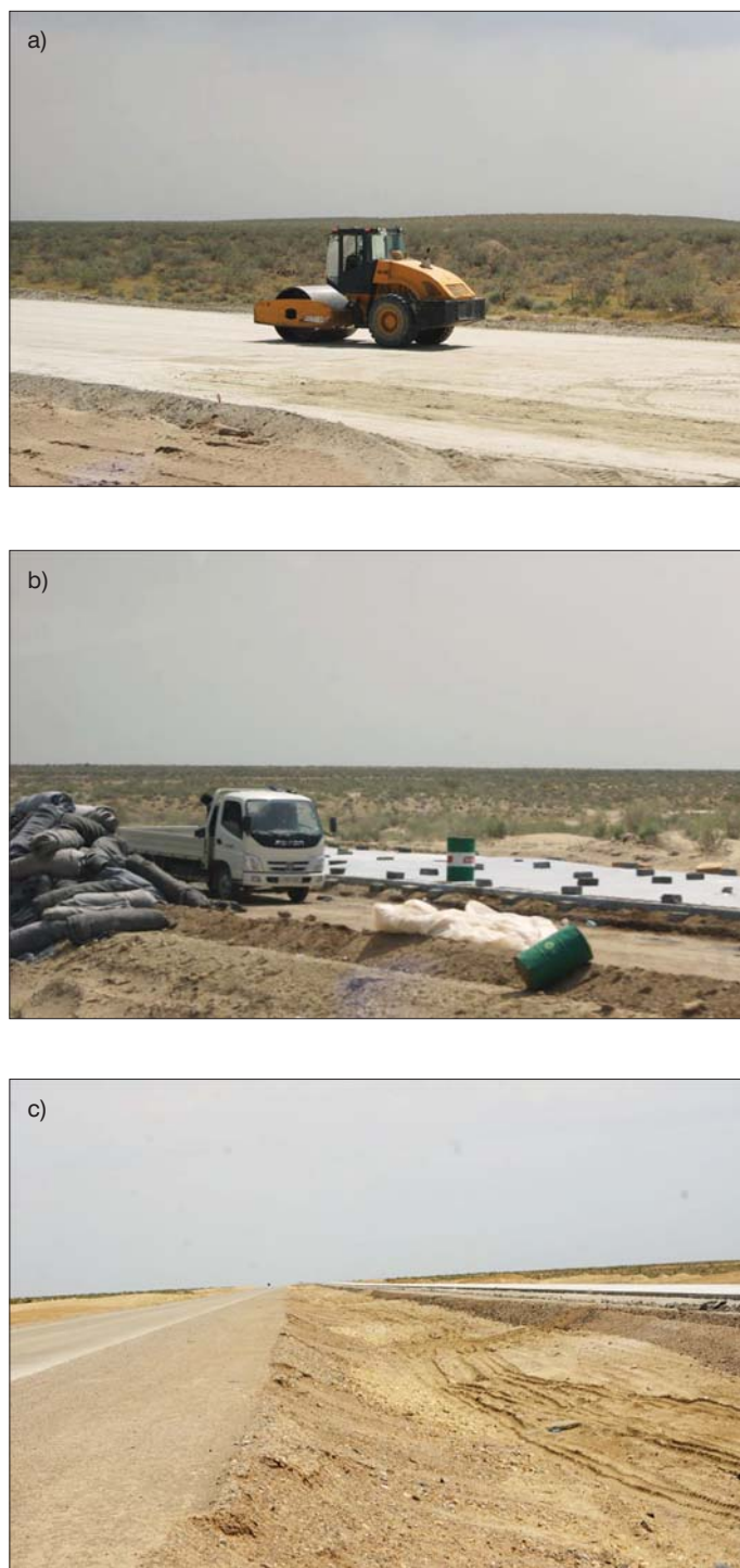
Fot. 2. Fazy budowy drogi wzdłuż Jedwabnego Szlaku: a, b i c
