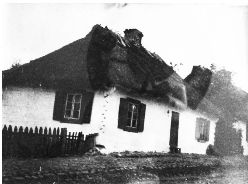
Ryc. 2. Pierwotny wygląd dwóch domów rodziny Grużewskich przy ul. Nowomiejskiej w Liwie; fot. z prywatnego archiwum rodziny Grużewskich
