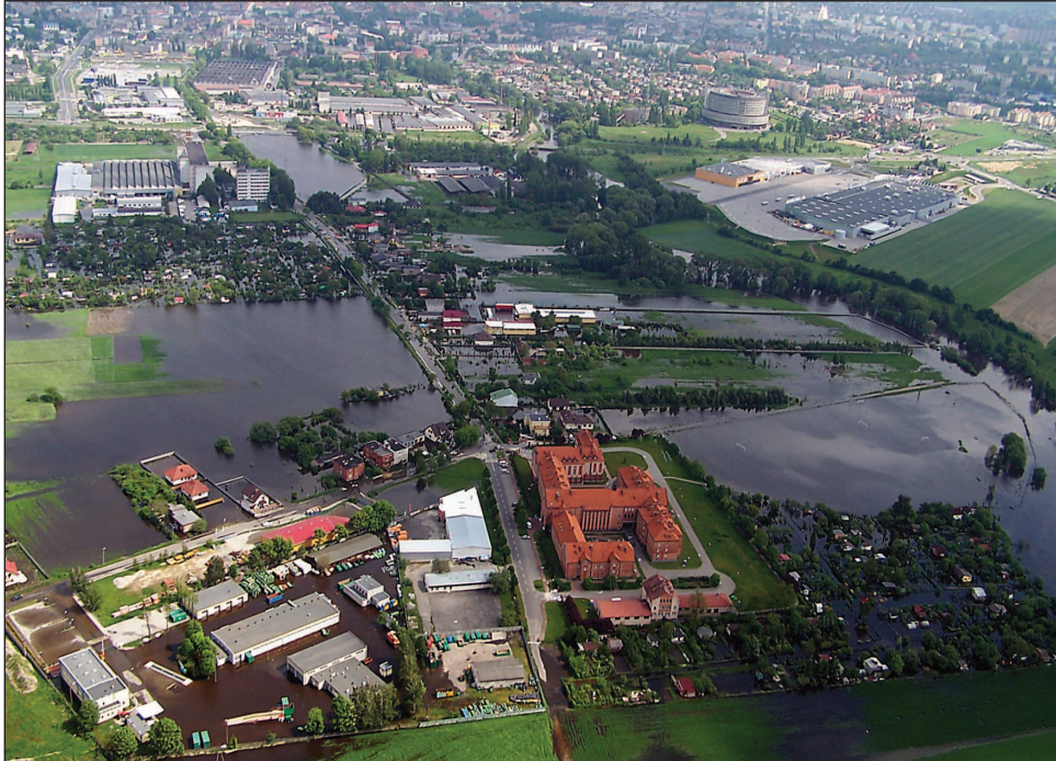
Fot. 5. Kalisz, obiekty Wyższego Seminarium Duchownego, powódź 2010 r.
