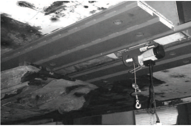
Rys. 2. Wzmocnienie stropu stanowiska do badań kinematyki i funkcjonalności sekcji obudowy zmechanizowanej [2]
